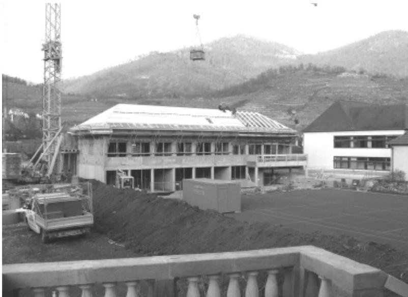
Bekanntlich waren beim Neubau der Volksschule **Komplikationen** aufgetreten, weil der Boden nicht die erforderliche Tragkraft aufweist. Nach Beiziehung eines Bodengutachters mussten Rammpfähle geschlagen werden. In diesem Zusammenhang wurde der Ertei-
